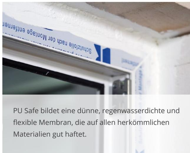
PU Safe bildet eine dünne, regenwasserdichte und flexible Membran, die auf allen herkömmlichen Materialien gut haftet.
